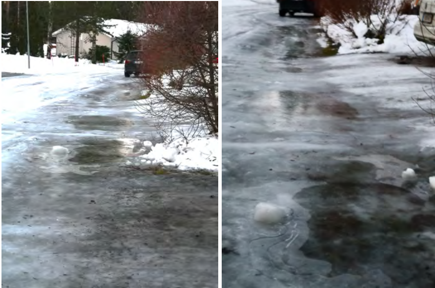
Kuva 1: Esimerkkejä (joulukuu 2022) veden kertymisestä tonttien rajalle ja Naavatie 7:n kohdalle kadun varteen ojan täyttämisen ja Naavatie 7:n ajorampin korottamisen seurauksena.
