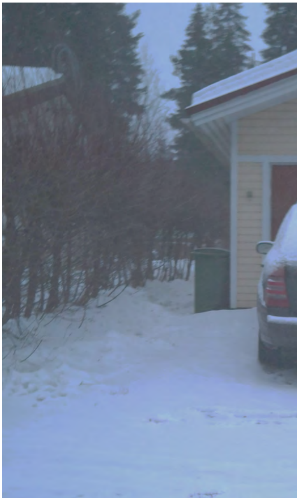
Kuva 2: Naavatie 5:n talousrakennuksen takaa näkee mikä on ollut vuonna 1986 luonteva maan pinnan taso, jotta Naavatie 5:n tontti olisi viettänyt tontin takaosasta hulevesien ohjaamiseksi kohti Naavatie varressa ollutta ojaa. Esimerkiksi talousrakennuksen vieressä oleva jäteastia on ympäröivään maahan nähden kuopassa Naavatie 7:n rakennusaikaisten maanrakennustöiden seurauksena.
